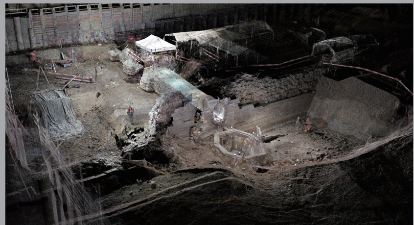
3 Excavation Site of Erweiterung Kunsthaus Zurich (Image: Matthias Vollmer, Data: Stadt Zurich)
